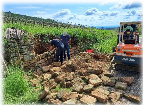
Reconstruction d'un mur en pierres sèches en régie communale en bordure de la RD435
