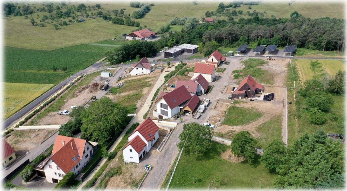
Vue d'ensemble du lotissement avec les ombrières
