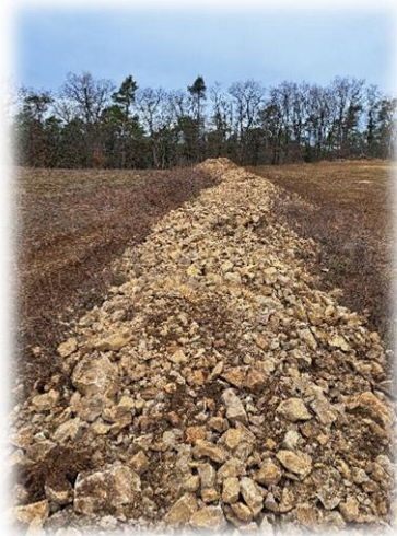
Création d'un pierrier sur la colline du Berg
