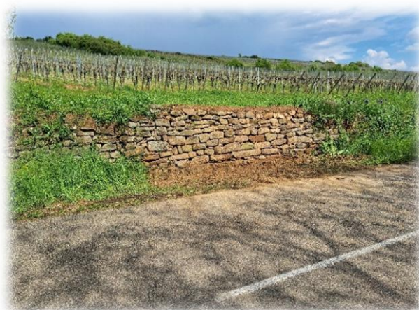
Reconstruction d'un mur en pierres sèches en régie communale en bordure de la RD435
