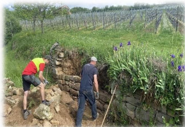
Reconstruction d'un mur en pierres sèches en régie communale en bordure de la RD435
