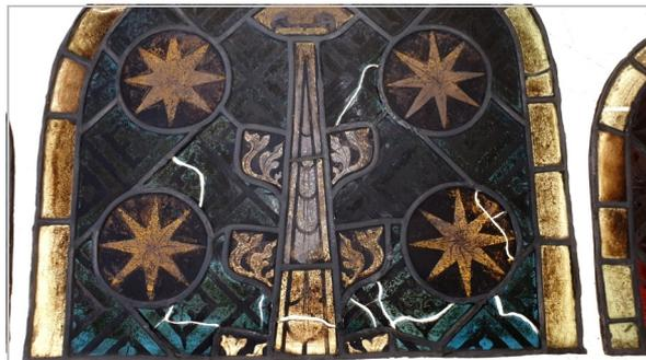
*Plombs de casse retirés. Les baguettes de plomb servaient à réparer le verre fendu.*
