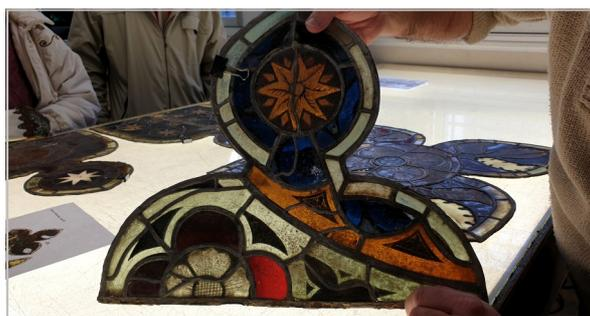
*Le nettoyage permet d'éclaircir le verre rendu opaque par le développement de micro-algues qui s'incrustent au fil des siècles.*
