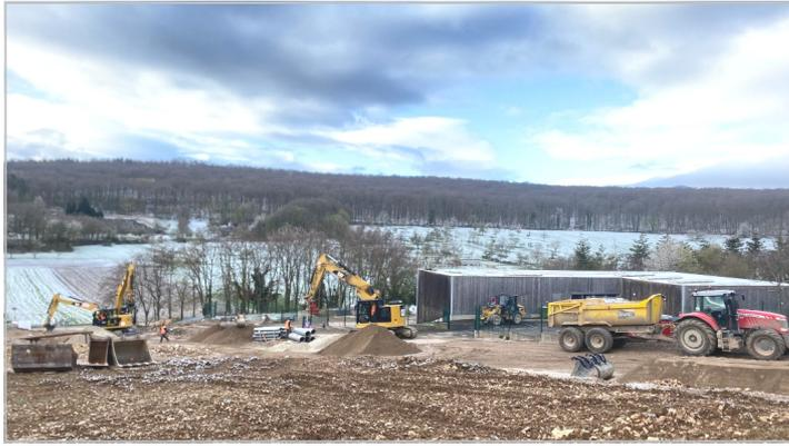
La **rue des Fauvettes** (voir page 5), au nord de la zone, a été tracée et stabilisée en premier afin de mettre en place une déviation, la rue de Gresswiller devant être coupée pour l'enfouissement du Tubao. Ce réservoir, d'une capacité de 512 m<sup>3</sup>, permettra le stockage des eaux de pluie et leur évacuation à faible débit dans le réseau d'eaux pluviales en cas de fortes précipitations.
