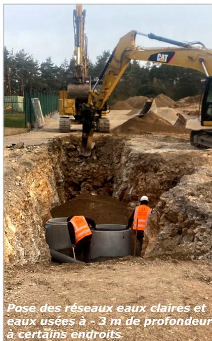
*Pose des réseaux eaux claires et eaux usées à - 3 m de profondeur à certains endroits*
