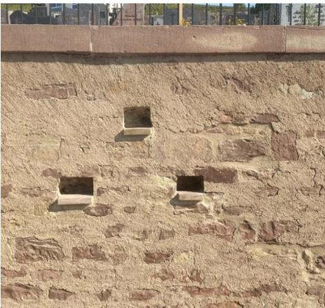
Le mur de soutènement du cimetière à l'entrée du village a bénéficié de travaux d'entretien et de valorisation. Un nettoyage haute pression a été effectué, ce qui a neutralisé les lichens. L'ensemble du crépi a été sonné pour repérer les parties non adhérentes, purgées et évacuées. Sur ces surfaces mises à nu, nous avons jointoyé les moellons façon « pierre vue ». Des cavités (ci-contre) ont été ex-
