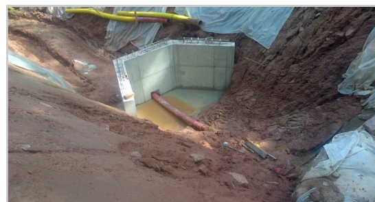
Mur de barrage pour recaptage source S4
