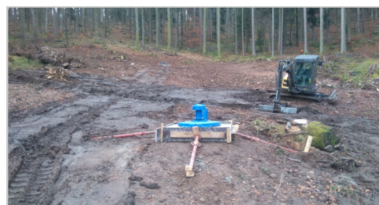
Terrassement et reprise des ouvrages sur S1
